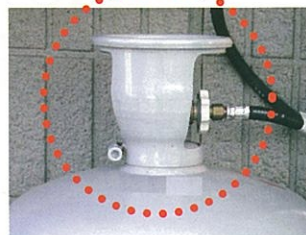
プロテクターを装着した50kgボンベ
