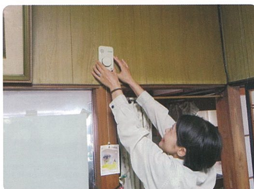
火災警報器の点検
