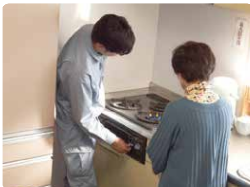
ガスコンロの点検
