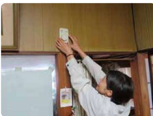
火災警報器の点検
