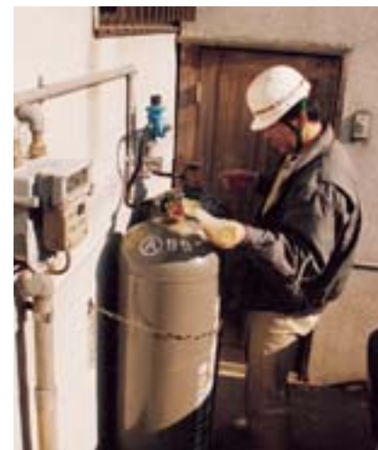
阪神淡路大震災の直後、LPガスの設備はいち早く点検された(兵庫県尼崎市)
