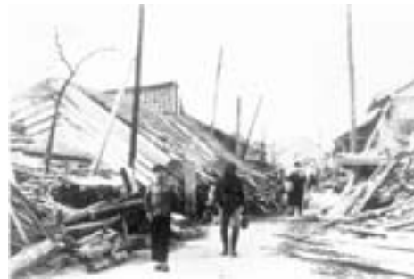
家屋の倒壊 四万十市大橋通二丁目付近
