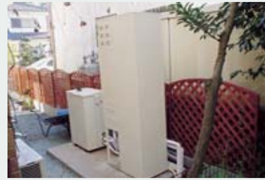
東京都内の一般家庭に設置された1キロワットのマイクロコージェネ（エコウィル）。
