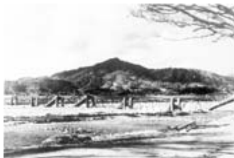
揺れによる橋の落下（9スパンのうち6スパンが落ちた。） 四万十市四万十川橋付近
