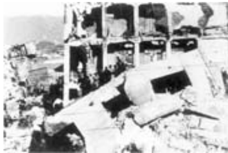
ビルの倒壊 高知市堺町付近
