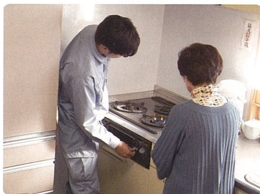
ガスコンロの点検
