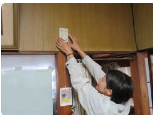
火災警報器の点検
